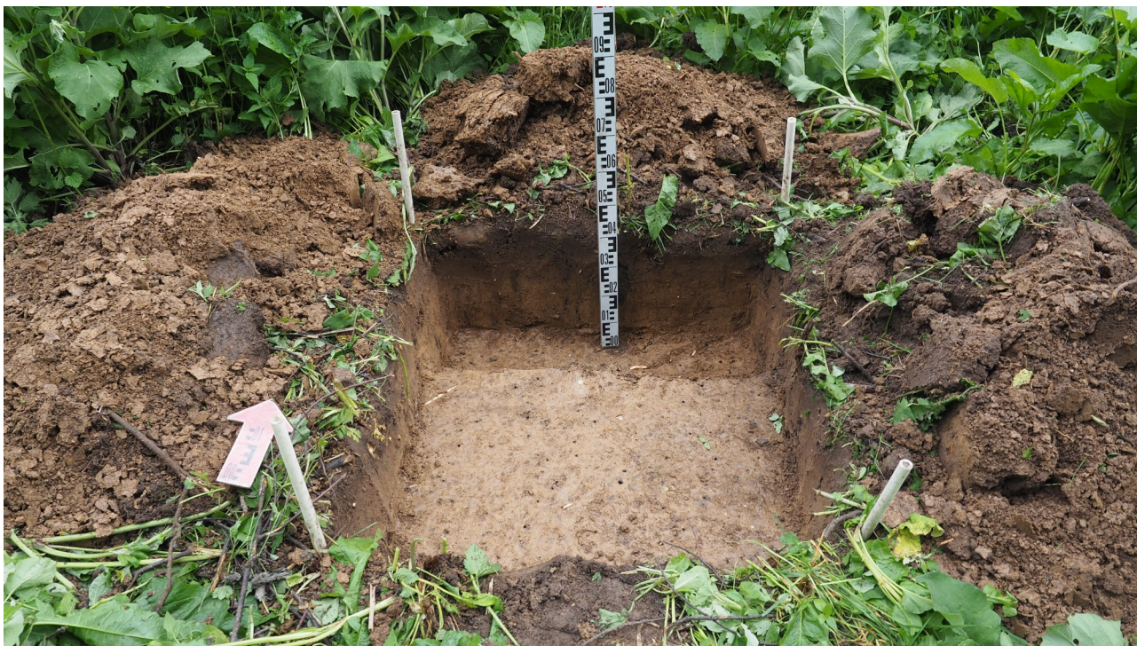
Рис. 40. Калужская область, Мещовский район. 2023 г. Археологическое обследование по объекту: «Уличные газопроводы дер. Тушенка». Шурф 3. Северная стенка с контрольным прокопом. Вид с юга.
